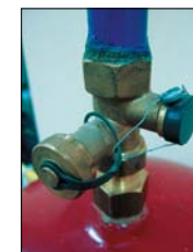
Многофункциональная арматура для расширительного бака
