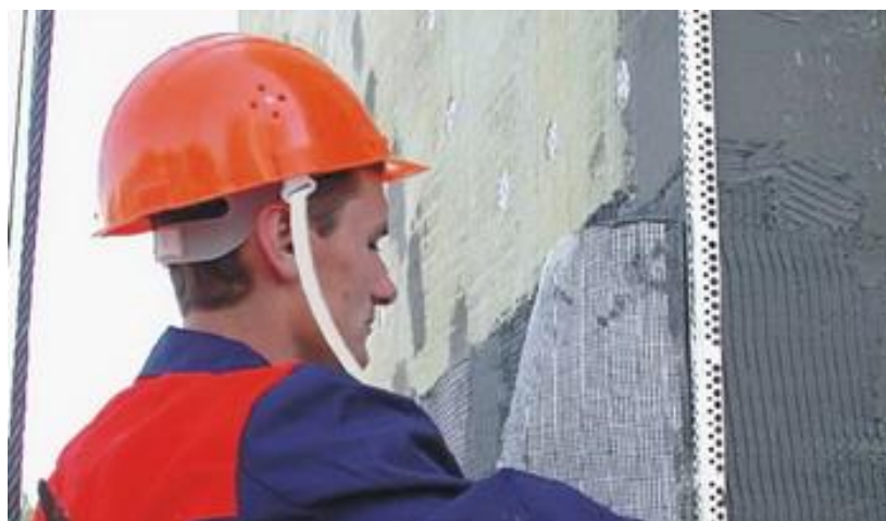
Рисунок 27 – Установка уголков
