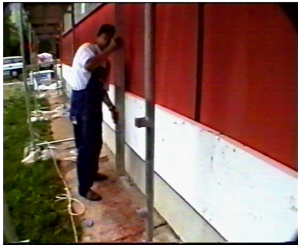
Рисунок 19 – Проверка ровности приклеенных плит утеплителя
