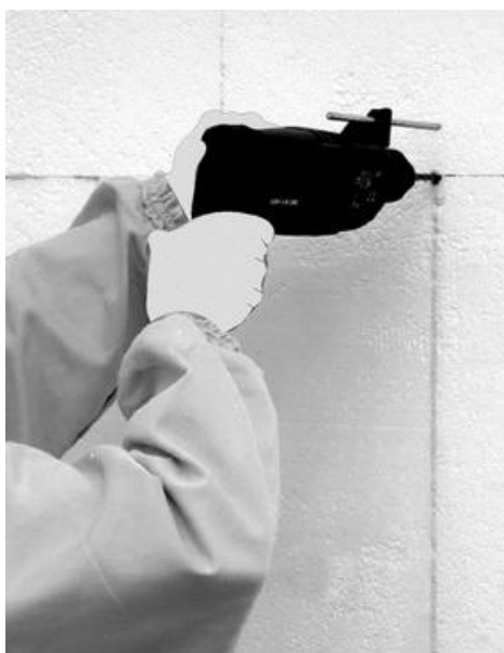
Рисунок 24 – Сверление отверстий электродрелью
