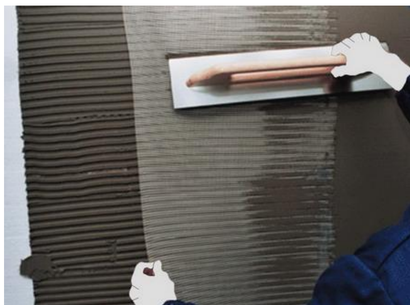
Рисунок 30 – Раскатывание и втапливание сетки в клеевой состав
