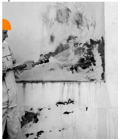
а - вручную с помощью металлической щетки; б - механизировано струей воды
