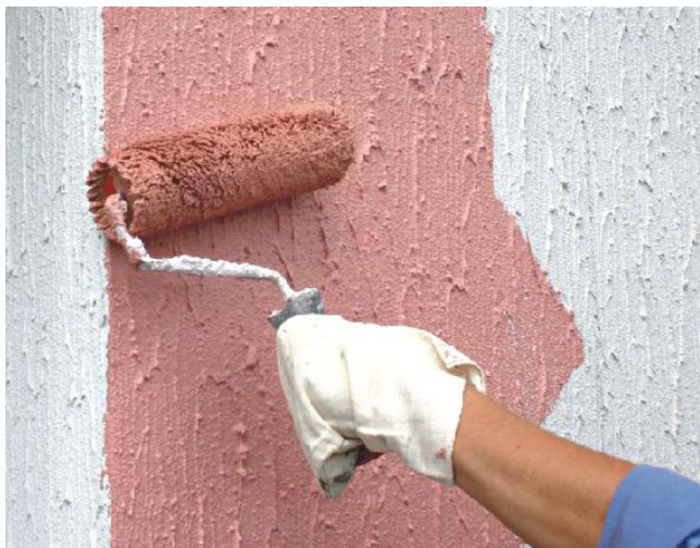
Рисунок 38 – Нанесение окрасочного состава «Термоколор» с помощью валика
