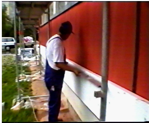
Рисунок 19 – Проверка ровности приклеенных плит утеплителя
