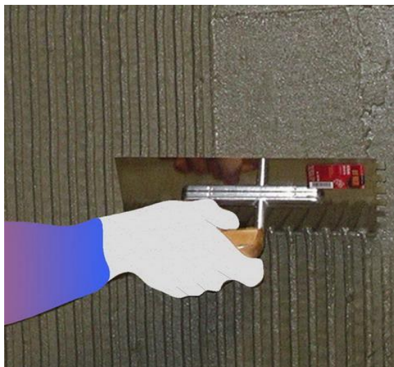
Рисунок 29 – Нанесение клеевого состава на плиты утеплителя
