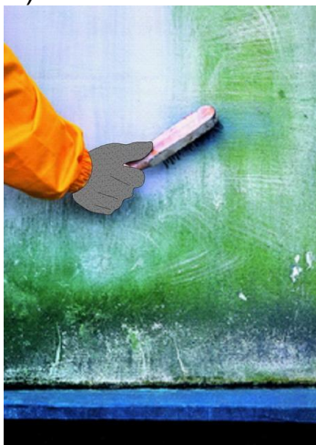
а - вручную с помощью металлической щетки; б - механизировано струей воды
