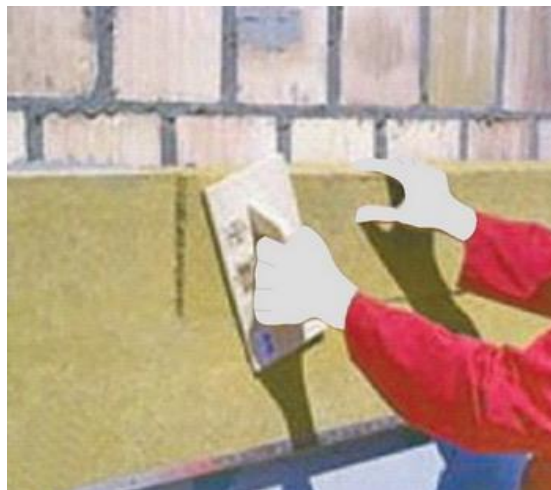
Рисунок 14 – Приклеивание плит утеплителя
