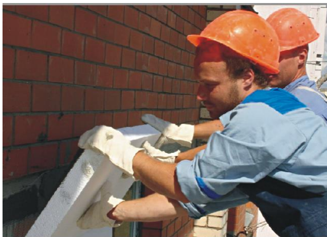
Рисунок 14 – Приклеивание плит утеплителя
