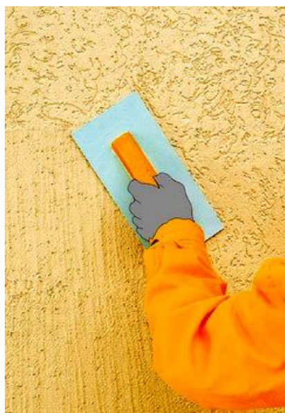
Рисунок 34 – Придание фактуры пластмассовой теркой
