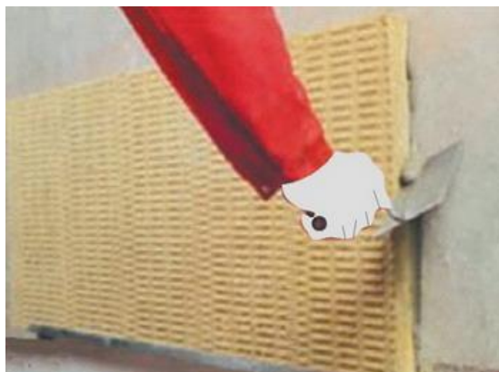
Рисунок 15 – Удаление лишнего клея
