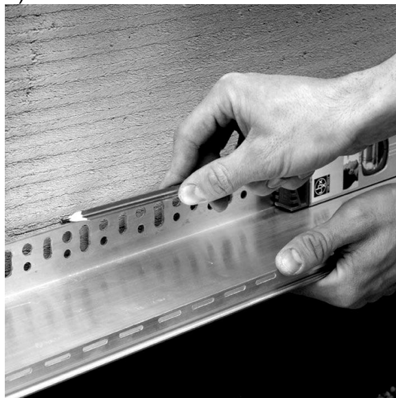
Рисунок 9 – Разметка мест установки цокольных планок
