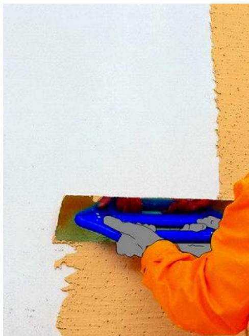
Рисунок 33 – Нанесение штукатурки металлической теркой
