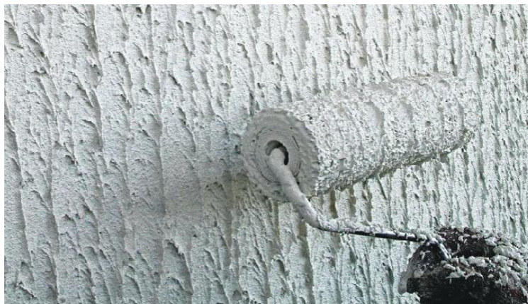
Рисунок 37 – Придание штукатурке необходимой фактуры с помощью структурного валика
