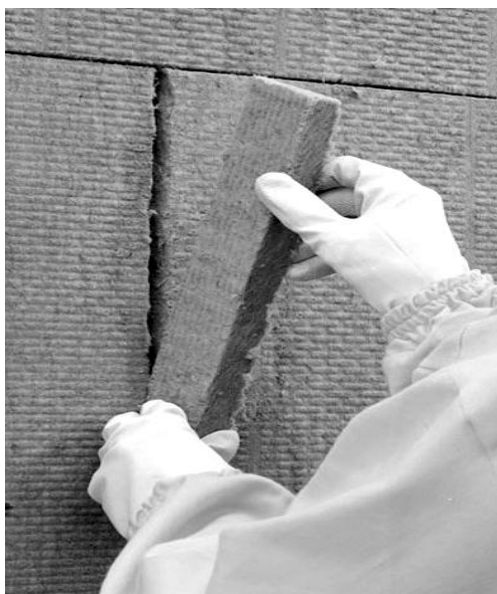
Рисунок 18 – Заделка щелей между теплоизоляционными плитами
