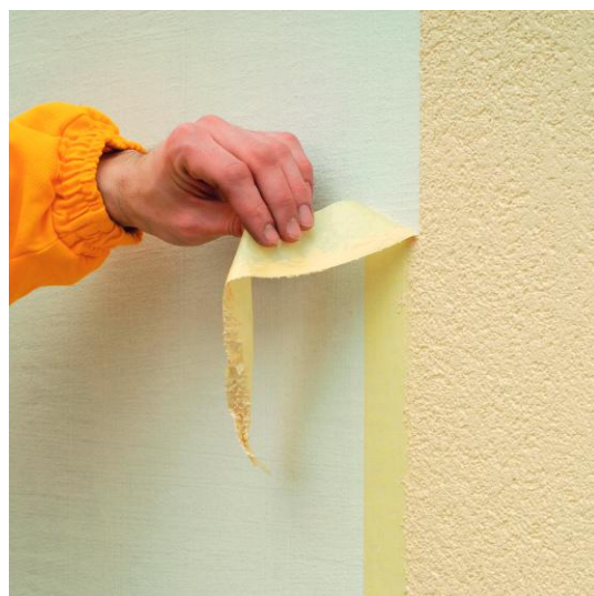
Рисунок 37 – Наклеивание и снятие самоклеющейся ленты
