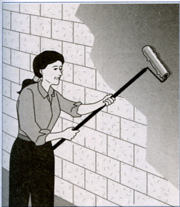
Валиком или жесткой щеткой нанесите на стены бетонную смесь.
