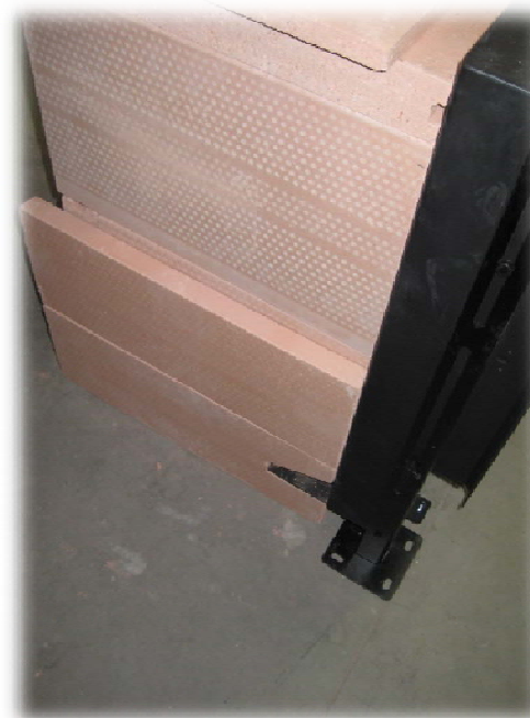
Зазор в области топки 4 см
