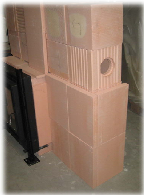
Зазор в области дымовых каналов
