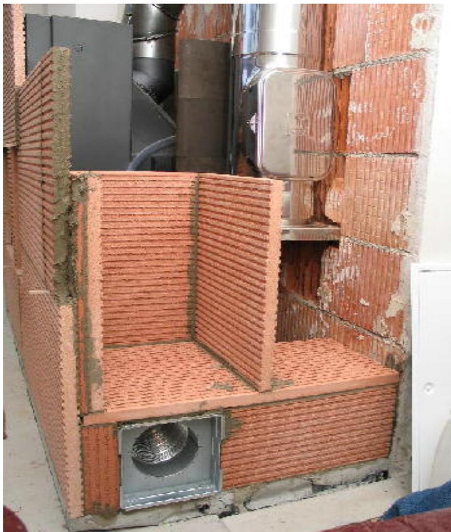
Из таких же плит с поверхностью под штукатурку собираются каналы для движения воздуха. Нагреваемый воздух попадает в конструкцию через отверстие, расположенное в нижней части.
