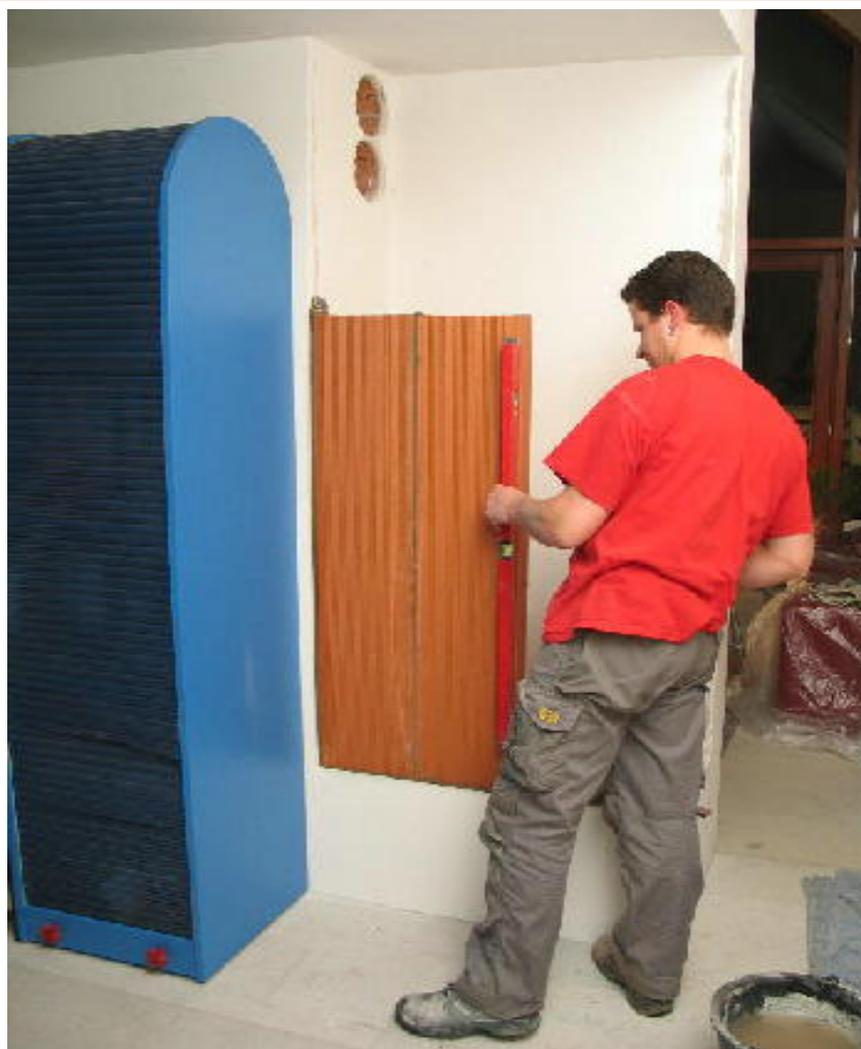
Для снижения теплового потока с задней стороны стены устанавливаются теплоизоляционные плиты «Хурдис».
