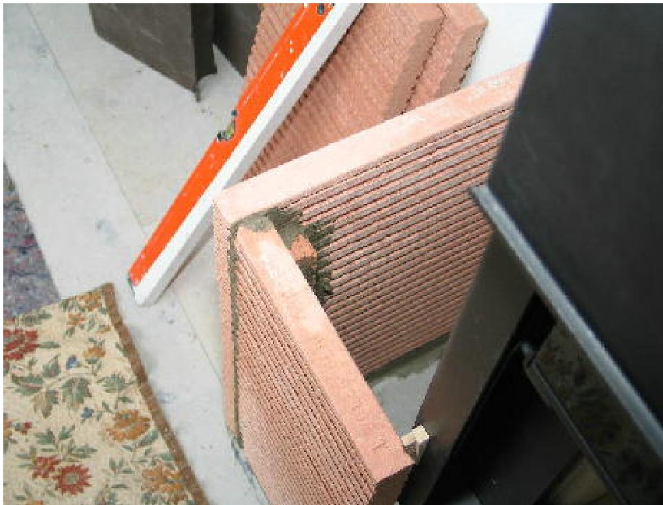
**Расстояние от стальной конструкции до шамотной оболочки может составлять от 1,5 до 15 см. Не допускать образования тепловых мостиков из остатков смеси.**
