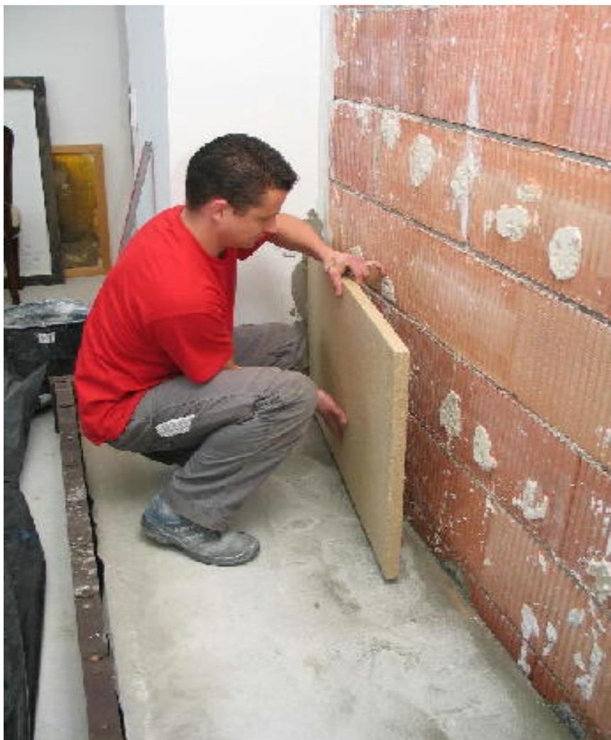
**Большой формат теплоизоляционных камней и плит позволяет охватывать большие площади, что ускоряет и упрощает монтаж.**
