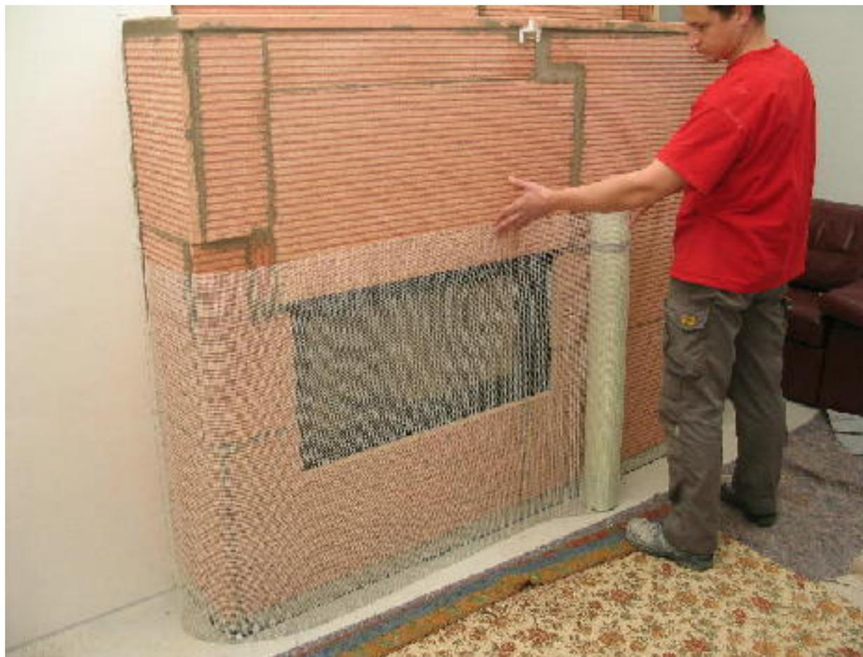
Штукатурку для отделки внешней поверхности теплоаккумулирующего камина наносят по сетке. Штукатурку можно использовать не только как финишную отделку но и в качестве основания под сетку.
