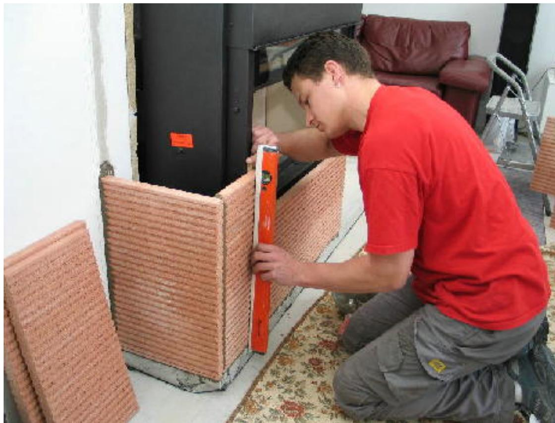
Постоянно проверять вертикальность и горизонтальность поверхностей при помощи строительного уровня.
