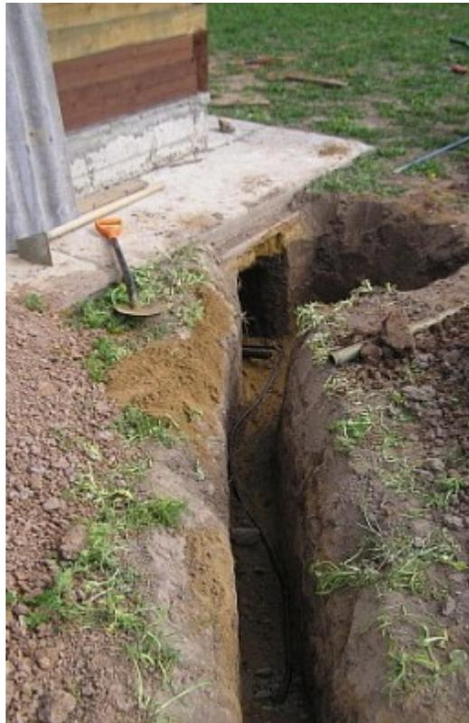
Для ввода в дом – используем отрезок металлической трубы (гильза) диаметром на 2-3 типоразмера больше диаметра гофры длиной на 20 см больше толщины стены или фундамента.
