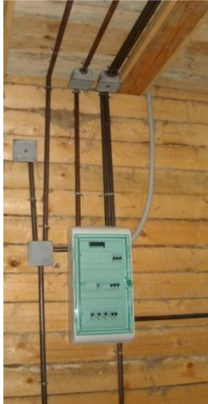
Первым делом необходимо обследовать и разметить трассу прокладки кабельных линий. Требуется выбрать самую оптимальную кабельную трассу, то есть монтаж металлических труб должен осуществляться с минимальным ущербом для деревянных стен и перекрытий, так как выдалбливание штроб и сверление отверстий в деревянных конструкциях ослабляет их основные функции.
