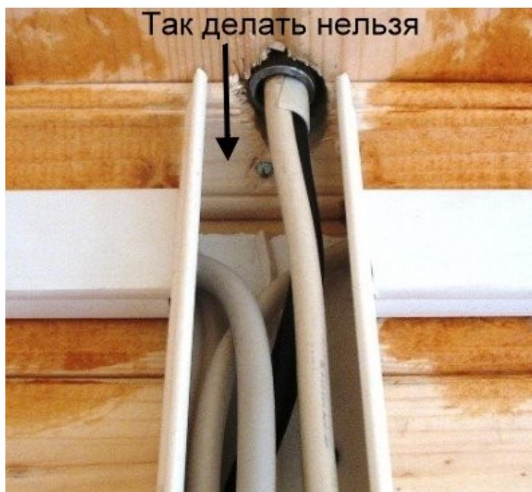
Электромонтаж открытой проводки должен быть выполнен в коробе, в электротехническом плинтусе или в пластиковой трубе, которые не поддерживают горение.
