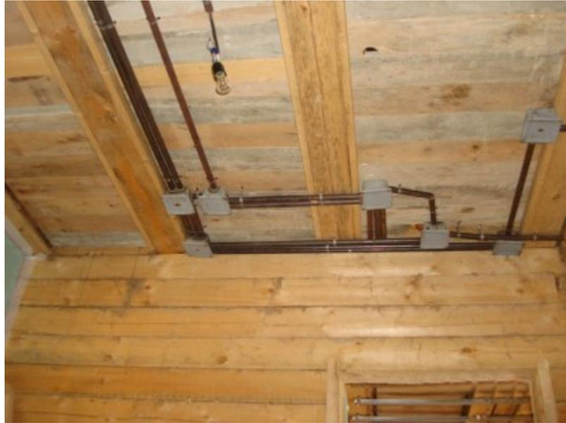
Если по условиям прокладки кабельной линии нет возможности проложить металлическую трубу с минимальными поворотами, то необходимо установить металлические протяжные распаечные коробки.
