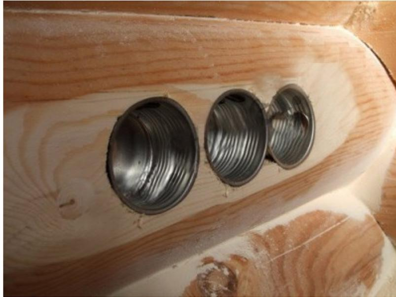
После прокладки металлических труб, приступаем к установке металлических монтажных коробок для розеток и выключателей.
