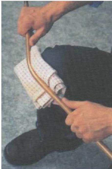
Медные трубы легко гнутся и их электромонтаж можно выполнить без дополнительного инструмента и электрооборудования.
