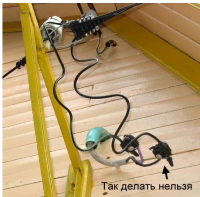
Выполнив электромонтаж вводного провода через металлическую гильзу внутрь дома, СИП прокладывается до главного распределительного щита (щит учёта). Способ прокладки может быть различен, то есть открытая или скрытая электропроводка - главным условием выбора способа прокладки являются требования электробезопасности и пожарной безопасности.
