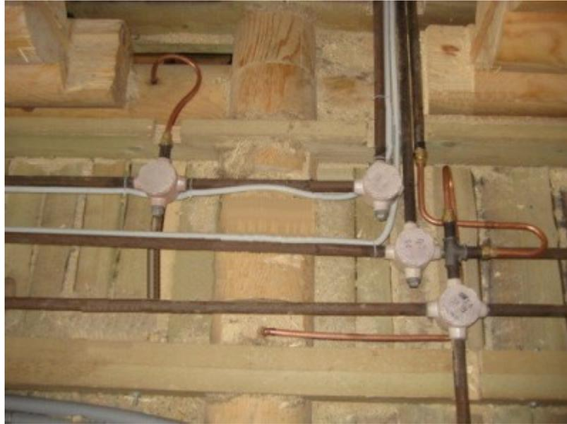
Выполнив электромонтажные работы по прокладке металлических труб и установке металлических распаечных, протяжных и монтажных коробок, необходимо сразу провести электроизмерения, а именно замер наличия цепи между заземлёнными установками и элементами заземлённой установки (металлосвязь), это позволит убедиться, что все металлические конструкции присоединены к шине «РЕ» и имеют непрерывность электрической цепи. Затем можно приступать к прокладке кабеля или провода в металлические трубы.
