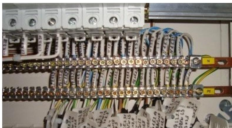
Далее необходимо подключить контур заземления к шине «РЕ». Это соединение так же необходимо выполнять при помощи болтов, шайб и гаек.
