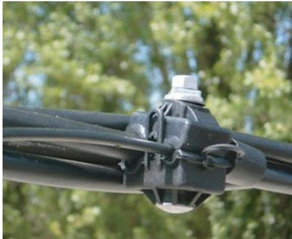
От опоры ВЛ (или установленной на вашем участке опоры) к стене дома СИП монтируется при помощи специальных анкерных креплений на высоте не менее 2,75 м от земли. От места крепления к стене до места прохождения через стену СИП должен быть проложен в гофрированной трубе ПВХ, коробе или в других несгораемых конструкциях.
