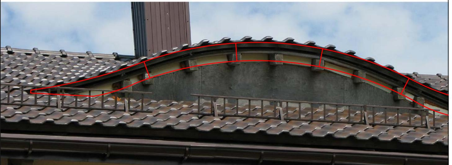
5. Сущ. плоскость фанеры обшить мелкогабаритной вагонкой (или рейкой напоминающей жалюзи). В местах указанных вертикальной желтой линией выполнить вертикальную расшивку (симметрично относительно центра).
