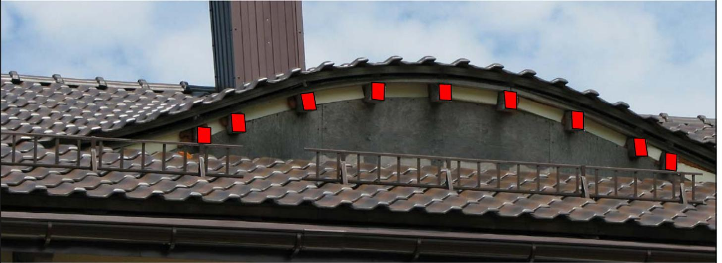
2. Разметить гибкой рейкой дугу, и подрезать кобылки до фанеры.
