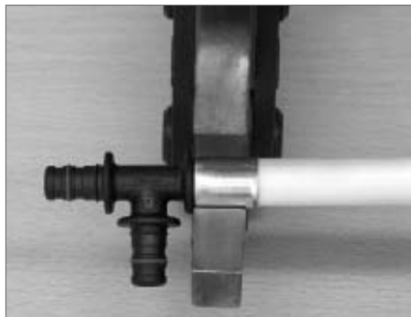
Рис. 43. После того, как кольцо придвинули к фланцу корпуса, следует разместить головку пресса так, чтобы она соприкасалась с фланцем корпуса, но не обхватывала его.
