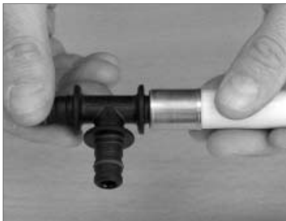
Рис. 42. После насадки трубы с кольцом на корпус фасонного изделия следует придвинуть кольцо к фланцу корпуса.
