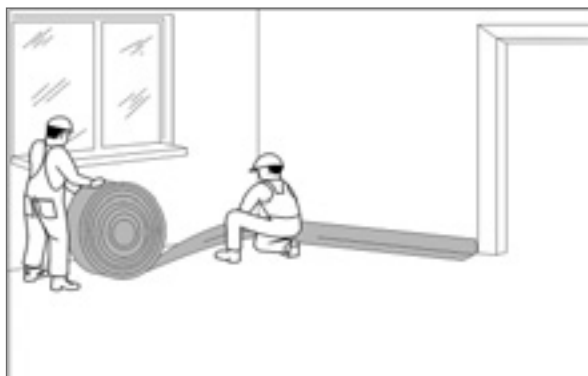
Рис. 140. Разложить под стеной изоляционную краевую ленту.
