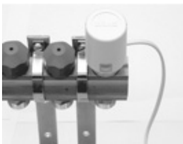
Рис. 154a. Электрический сервомотор установлен на запорном вентиле, вмонтированном на подающем коллекторе распределителя.
